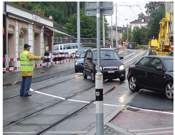
Exemplaire : Il est souvent adéquat d'employer des personnes qui informent les usagers et leur indiquent le chemin.
